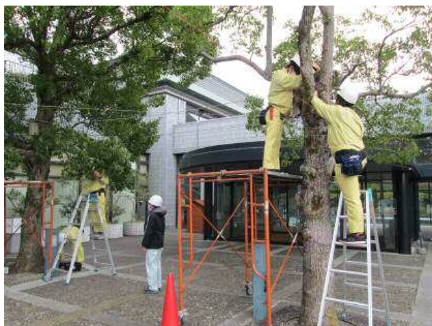
電飾、配線の取付作業の様子
